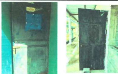
Foto1: Mantenimiento a puertas metálicas existentes retiro de óxido, suciedad y pintura deteriorada; incluye cepillado, lijado y aplicación de pintura.
