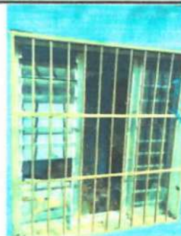
Foto 2: Sustitución de ventanas; sistema de apertura: Corredizas, Perfiles color blanco estandar, Material del marco: PVC Material de la ventana: Vidrio, sellado perimetral.
